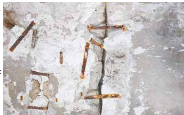
Укрепление плиты металлическими скобами из стали
